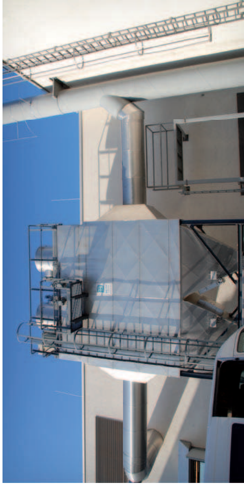
Rauchgasreinigung durch Elektrofilter
